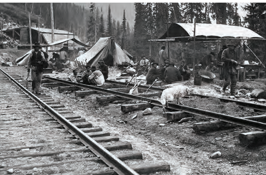
3.32 Des travailleurs chinois à l'œuvre sur le chemin de fer transcontinental au col Rogers, en Colombie-Britannique. On estime à environ 15 000 le nombre de Chinois ayant participé à la construction du chemin de fer transcontinental.
